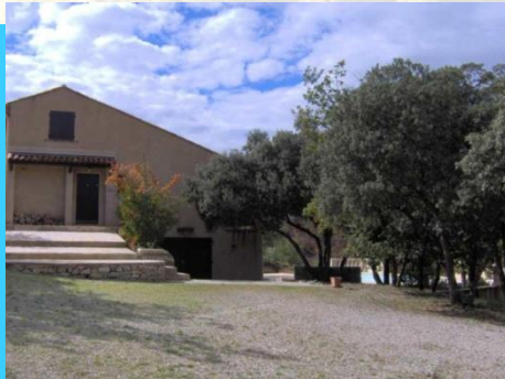
■ pas de dégâts
