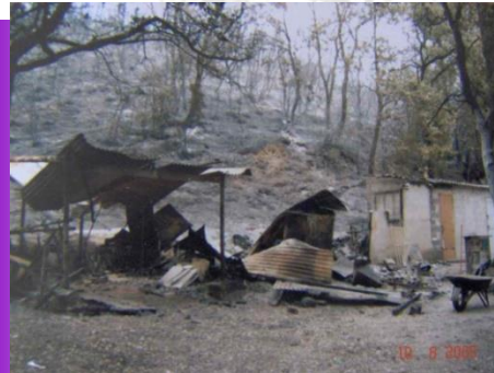
■ dégâts à une installation périphérique à l'habitation
